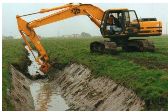
Figure 20 : Exemples de curage et reprofilage de fossé
