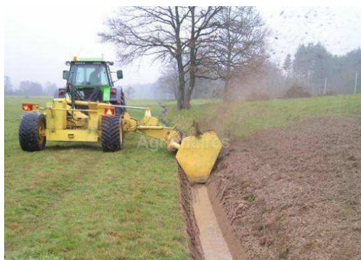
Figure 20 : Exemples de curage et reprofilage de fossé
