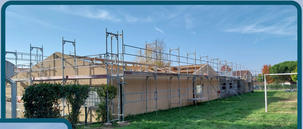
Dépose des toitures
