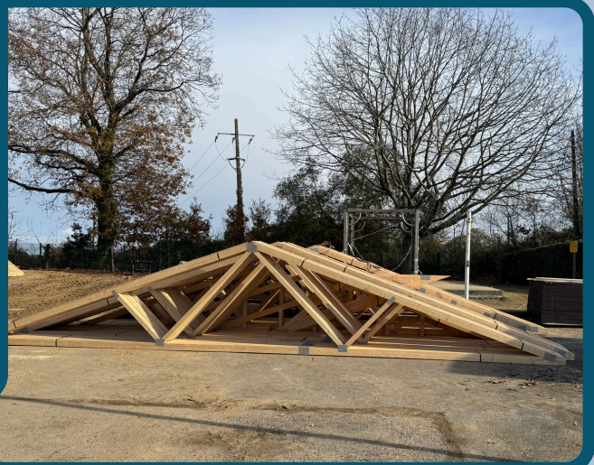
Pose des nouvelles charpentes
