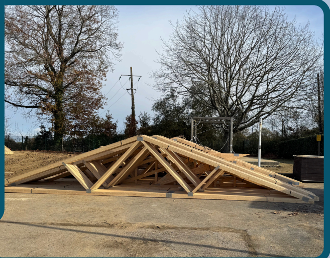
Pose des nouvelles charpentes
