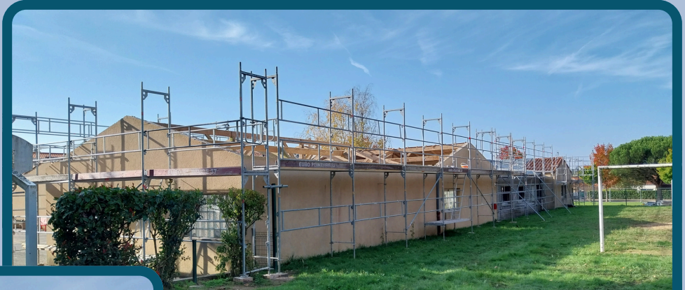
Dépose des toitures
