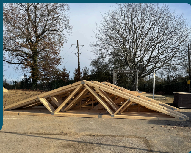
Pose des nouvelles charpentes
