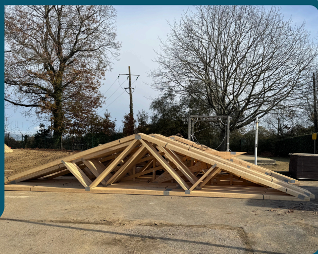
Pose des nouvelles charpentes
